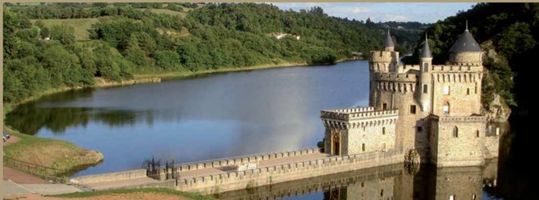
Château de St-Priest-la-Roche
